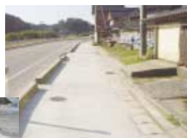
歩道舗装工事
