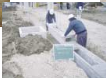
区画整理 側溝工事
