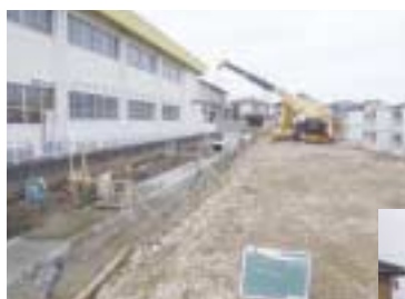
ボックスカルバート布設工事
