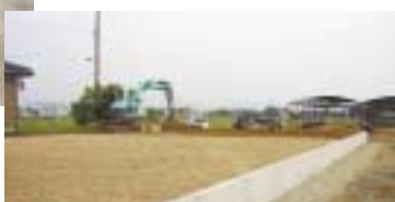
宅地造成工事
